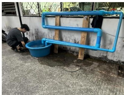
รูปภาพที่ 3.8 ติดตั้งท่อและติดกล่องอุปกรณ์
